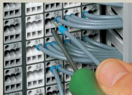
Подсоединение проводов с наконечниками
