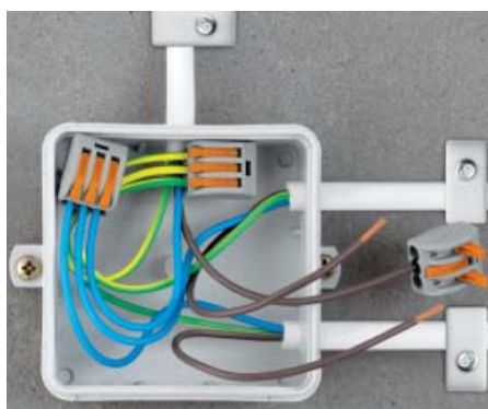
Подключение гибких проводников в распределительной коробке
