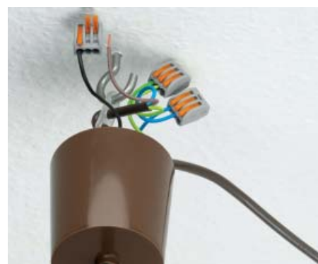
Петлевое подключение осветительного прибора гибкими проводниками.
