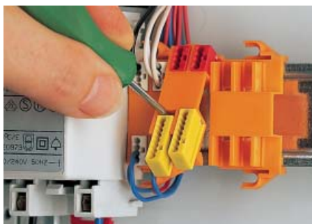
Демонтаж клеммы с кронштейна
