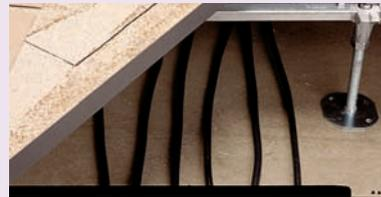
3. Установить оборудование, не допуская давления кабелей на механизмы
