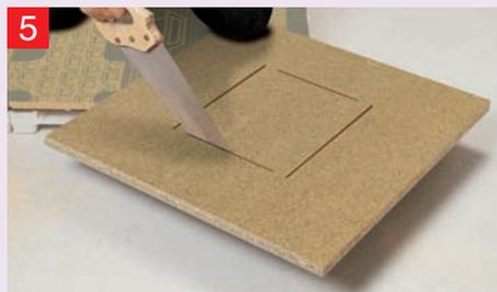
5 Напольные коробки: их установка не вызывает трудностей ввиду наличия специальной плиты для напольной коробки Кат.№ 309 39
