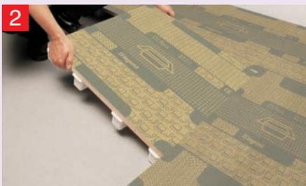
2 Установка плит в сборе: для того, чтобы упростить операции по установке, плиты поставляются в собранном виде с затянутыми винтами
