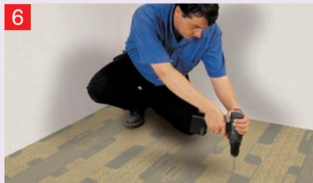
6 Закрепление плит: высококачественная отделка плит позволяет укладывать на них впоследствии любые напольные покрытия
