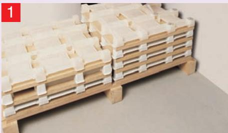
1 Подготовка плит: разбухающий клей наносится на основание каждого из 16 опорных выступов (толщина 1 см) так, чтобы компенсировать неровности и обеспечить надежное крепление
